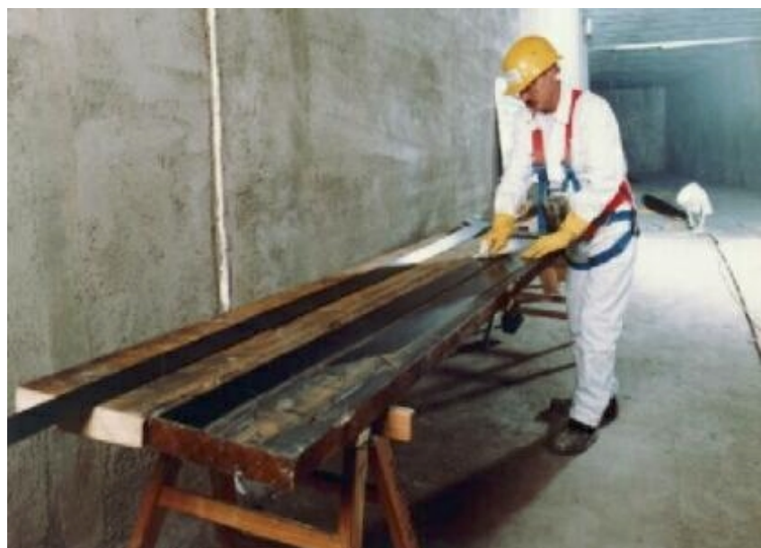
Bild 3: Reinigen der Lamellen im Inneren des RRB
