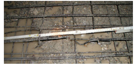
Bild 3. Fläche und Bewehrung nach Betonabtrag
